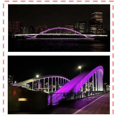
↑ 隅田川橋梁群(築地大橋) ※イメージ
