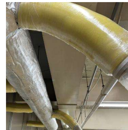
パイプ断熱材とハンディラップによる結露防止
