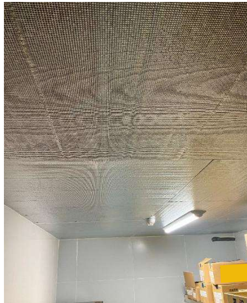
アルミロールマットによる断熱
