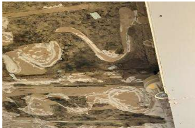
冷蔵庫の天井裏
